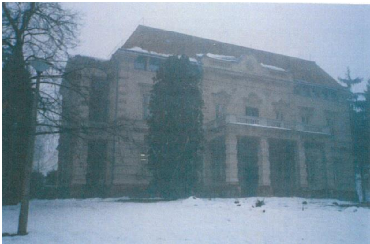
Kiskastély, kórház ép. Fő u. 57. 295 hrsz.
